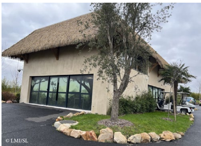
Un des bâtiments accueillant une des deux salles informatiques du Zoo de Beauval.
